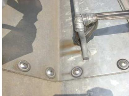
ビニールの結び目より水滴が滴下し、めっき被膜が磨耗した部位。
