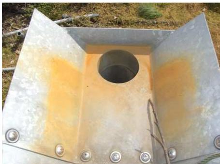
他の部位で発生した錆汁が流れる落とし口に発生したもらい錆
