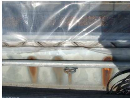
ビニールの緩み部分より水滴が滴下し、めっき皮膜が磨耗した部位。
